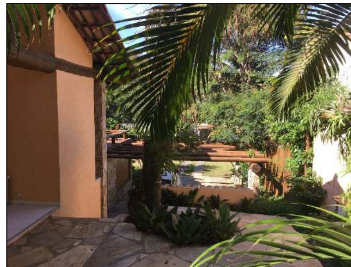
Acesso ao pavimento superior
